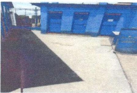
Foto 5: Con la reparación de planchas de concreto en el patio del módulo de baños, se evita el lodo que se produce al momento de lavar los mismos así como en el tiempo de invierno.
